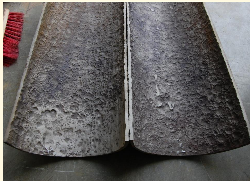
Prøve av samme vannledningen etter sandblåsing i 2009 (Breivoll inspection)
